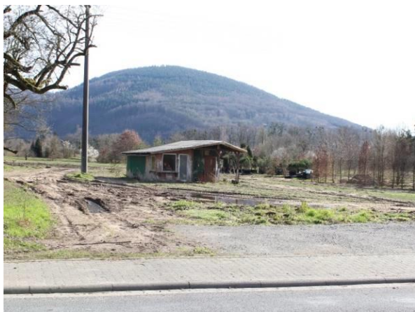
Schotterfläche, baufällige Hütte (Blick von Norden)
