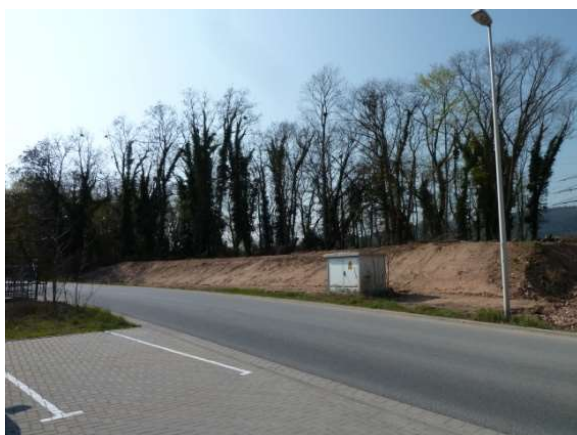
1: Biotop mit neu aufgeschütteter Böschung
