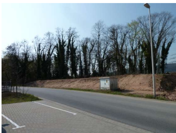
1: Biotop mit neu aufgeschütteter Böschung
